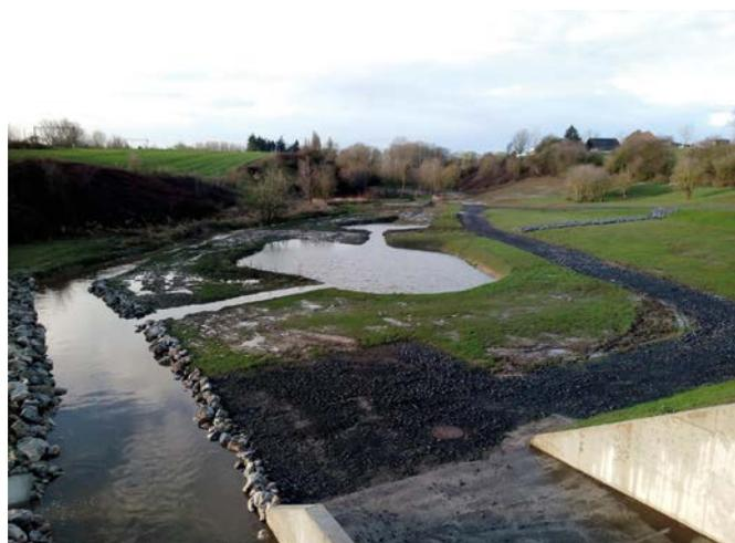
Zone de rétention se remplit et s'étend sur toute la surface déterminant la Zone d'immersion temporaire. Après l'épisode pluvieux, la Zone d'immersion temporaire se vide progressivement, tout en maintenant un débit limité par l'ouvrage de calibration vers l'aval.
