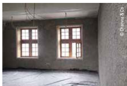
Une pièce après l'application de l'isolation
