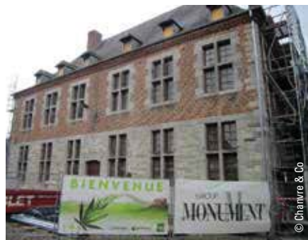
Le bâtiment classé en cours de rénovation
