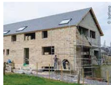
Isolation par l'extérieur d'une maison
