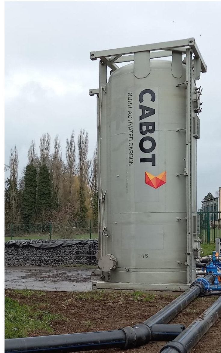
Filtre à charbon actif dans une station de traitement d'eau
