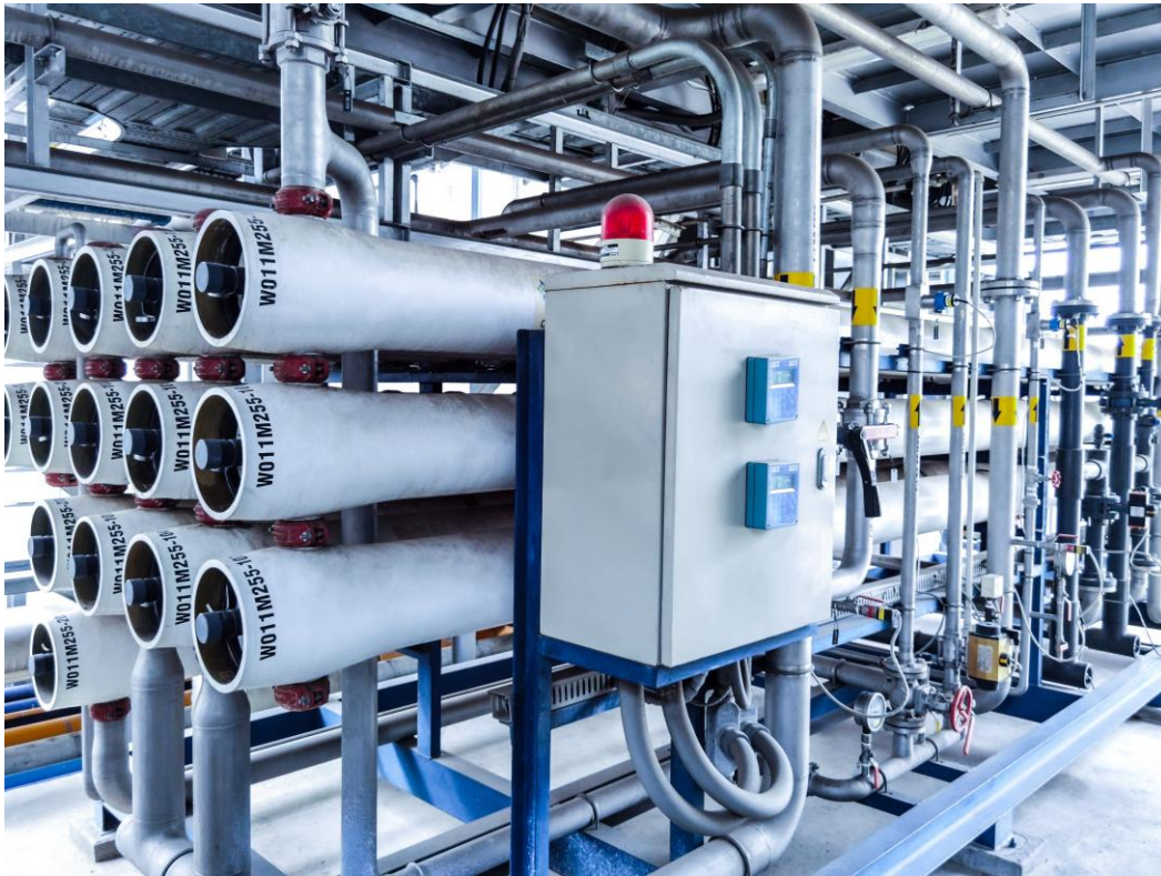
Osmose inverse dans une usine de traitement d'eau
