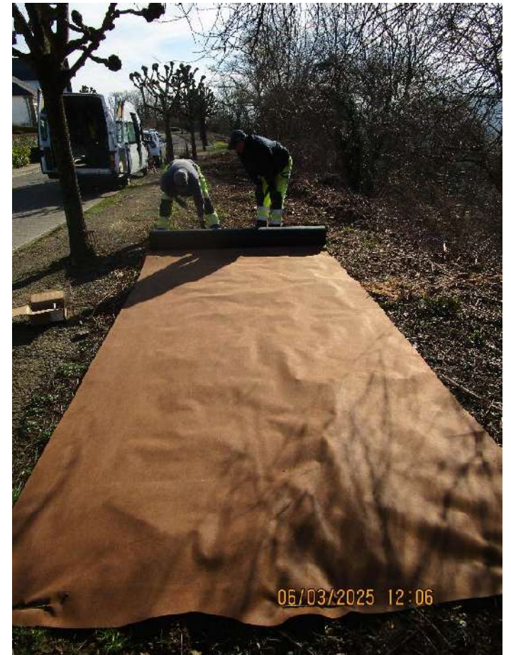
Pose d'un voile anti-racines résistant
